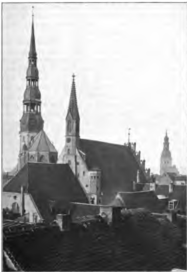
Abb. 18. Die St. Petri-, St. Johannis- und Domkirche. Nach einer Aufnahme des Architekten W. Bockslaff.
